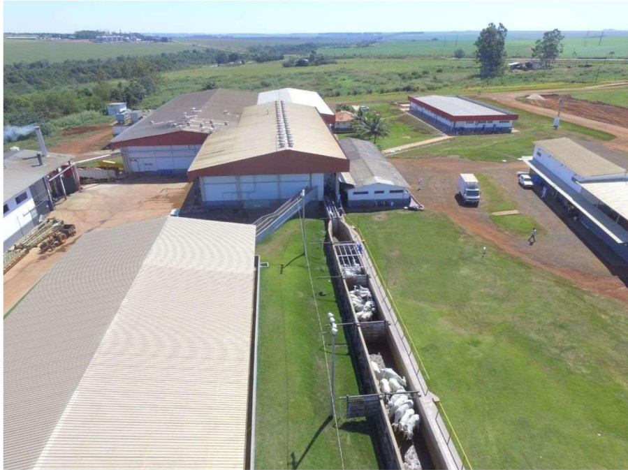
Rampa de acesso a sala de abate
